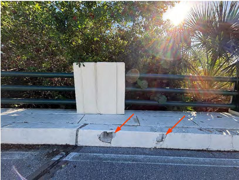
PHOTO 3 – TYPICAL PAINT FAILURE
